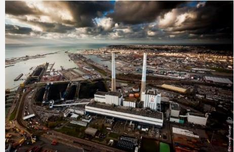
La centrale a une puissance installée de 600 MW et se compose d'une unité de production, qui vient de réaliser un important programme de modernisation. Sa proximité immédiate avec la mer permet le déchargement à quai des minéraliers et le refroidissement de l'unité de production par l'eau de mer.
